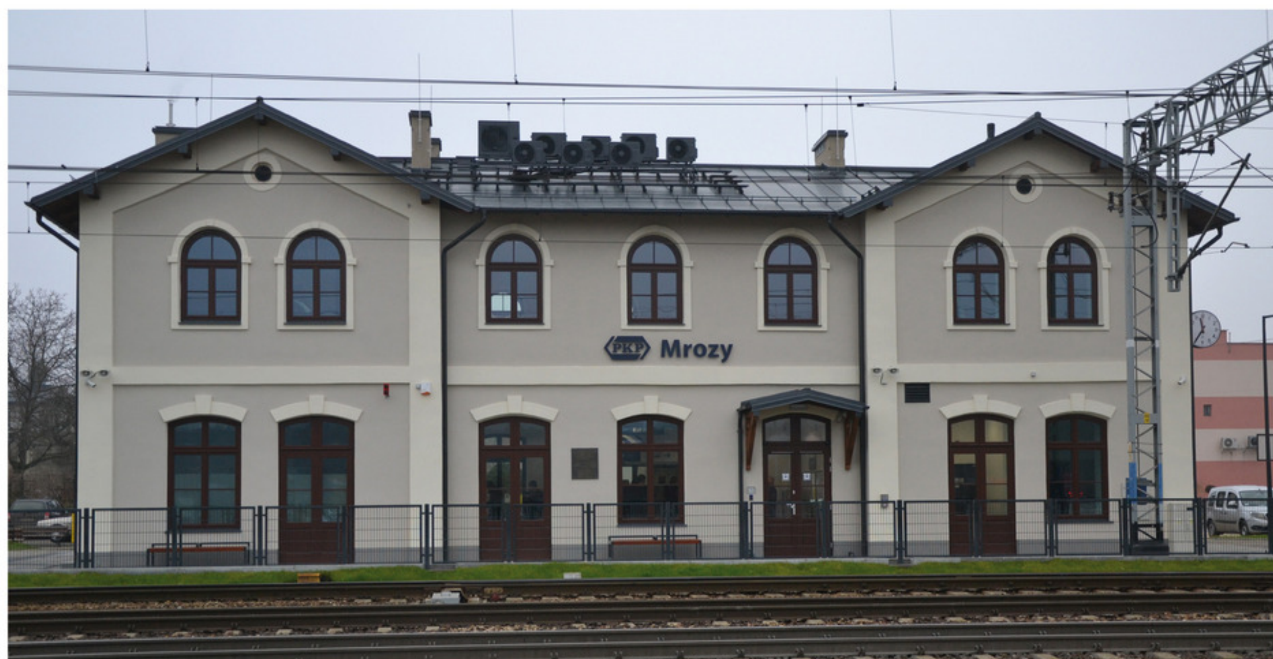
Dworzec PKP w Mrozach po remoncie
