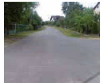
Budowa drogi – Lipiny
