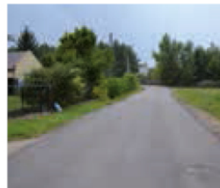
Budowa drogi – Mrozy, ul. Prosta
