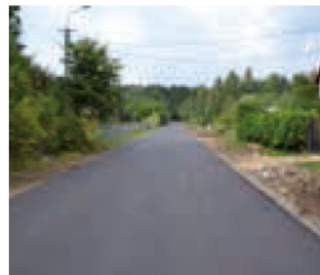
Budowa drogi – Mrozy, ul. 3 Maja
