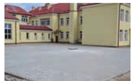
Budowa parkingu – Szkoła Podstawowa w Mrozach
